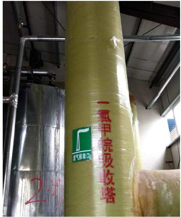
一氯甲烷吸收塔
