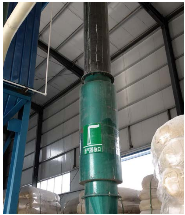
烘干系统布袋除尘器排气筒
