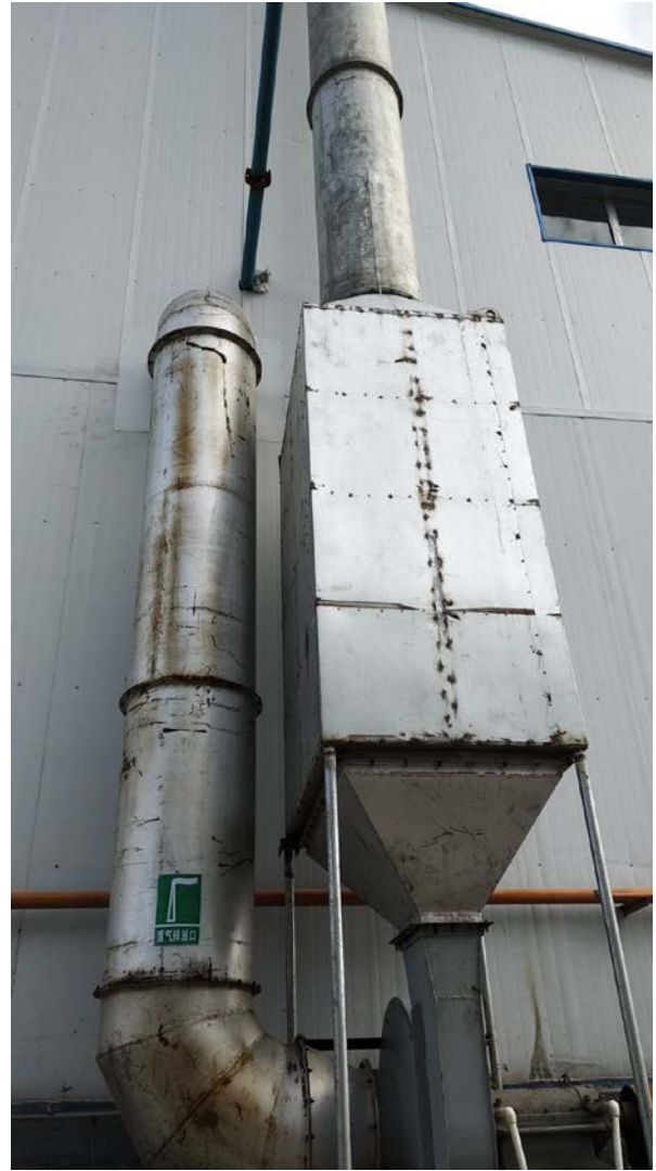
热风炉风机消音器设施照片
