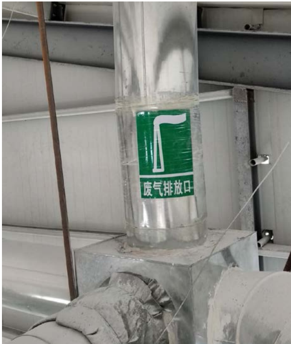
粉碎包装系统布袋除尘器排气筒
