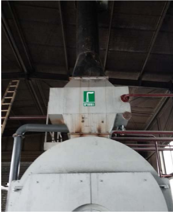
锅炉及排气筒
